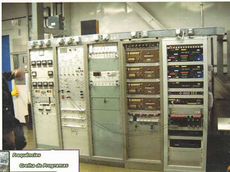
Schakelpaneel van Merlin Radio
